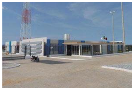
Sede da Energisa em Patos (PB)
