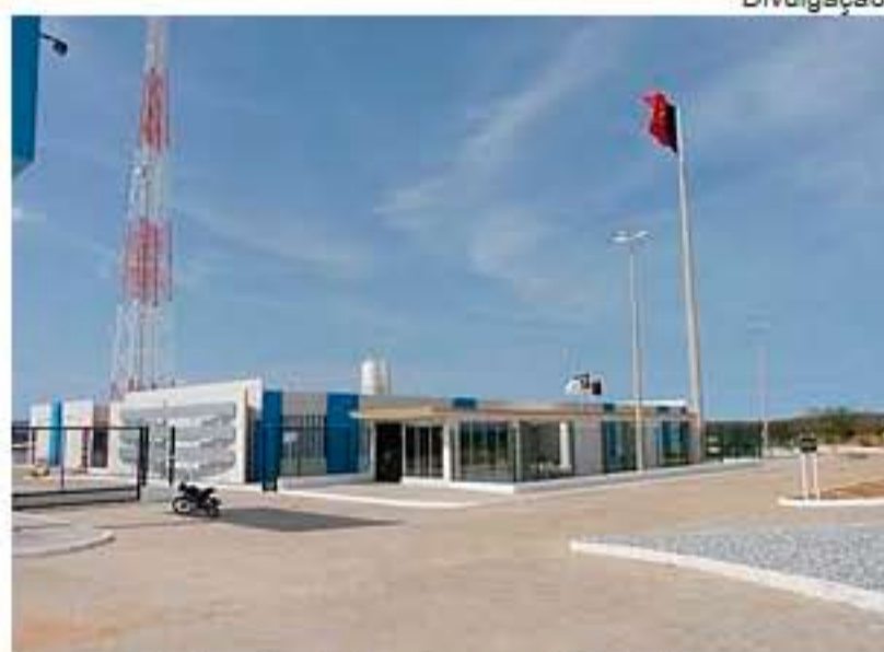
Construção de sede da Energisa em Patos (PB), que conseguiu o certificado ambiental Leed
